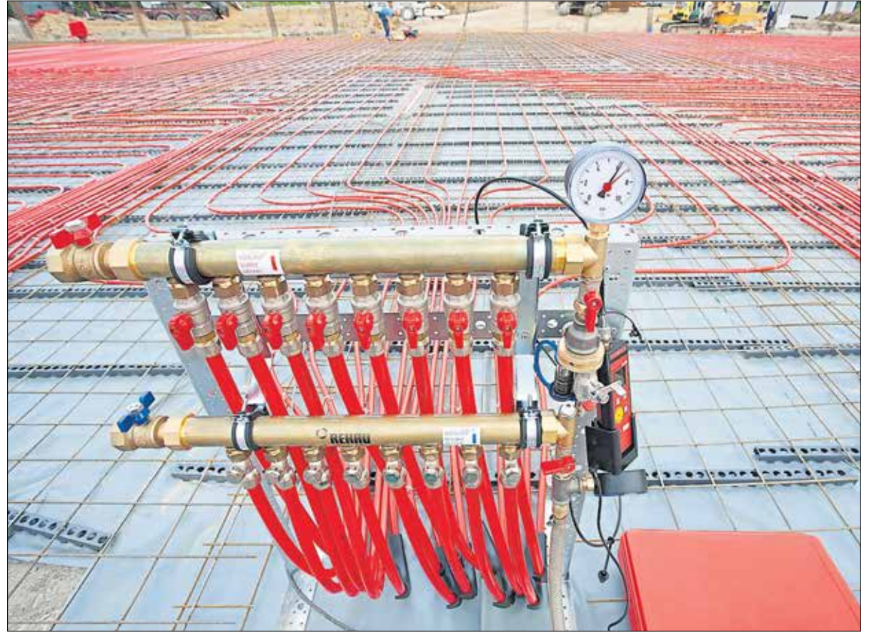
Bei der Betonkernaktivierung werden Rohrleitungen in die Betonbauteile eingelegt.
