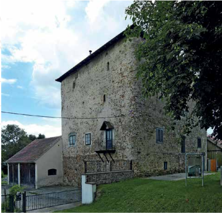
Abbildung 4: Der „Körnerkasten“, ein ehemaliges Tor des Kastells Cannabiaca/Zeiselmayer (Niederösterreich) zeigt: Werden massive Bauteile entsprechend instandgehalten, kann die Nutzungsdauer unter gewöhnlichen Randbedingungen fast beliebig verlängert werden. © BDA, Foto: Bettina Neubauer-Pregl
